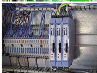
変換器には表示部・操作部のないMemoRailを採用し、イニシャルコスト低下と省スペース化を達成。測定データはアナログ伝送にて制御キャビネットに設置されたデータロガーに転送され、さらにTCP/IP経由で中央制御室に送られる。
