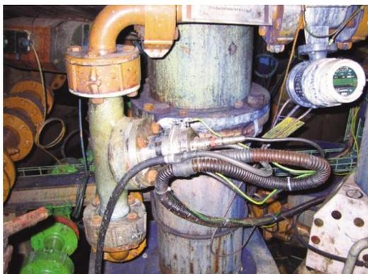
合成染料製造プロセスでは、各プロセスにおけるpH管理が非常に重要となる。ジアゾ化・カップリングの際には、強酸性・腐食性の薬品を用いるため、センサー・フィッティングともに非常に過酷な条件となる。また高温・高圧条件下での測定となるケースもある。
