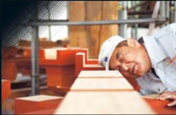
【上】—— 槍鉋(やりかん)など、伝統的な大工道具。これらの道具のつくり手も、伝統工法の存続には不可欠である。 【下】—— 現場での西澤氏。まずは自らの「眼」によって、表面の微妙な傾きや仕上げの状況を確認する。
