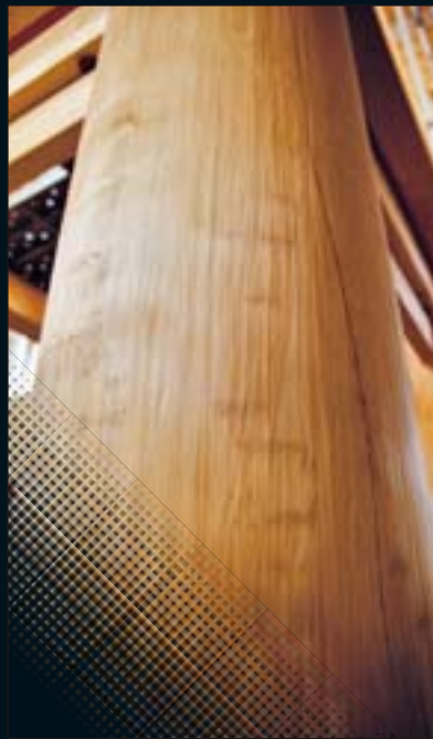
【上】—— 三重塔の心柱。日本の伝統的な塔の耐震性の高さは、この心柱を中心とする独自の構造によっている。
