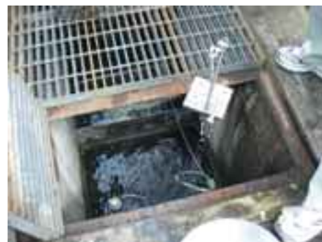
排水柵底土サンプリング風景
