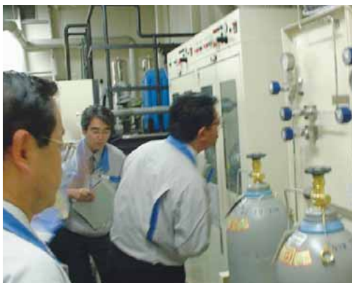
ガス供給装置の点検
