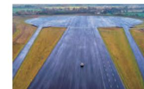
直線1km、直径300mの制御可能通信網を備えた高速限界挙動評価システム
