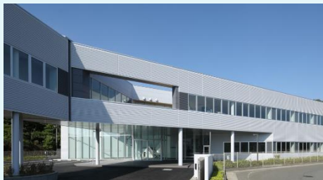
2025 福知山テクノロジーセンター
