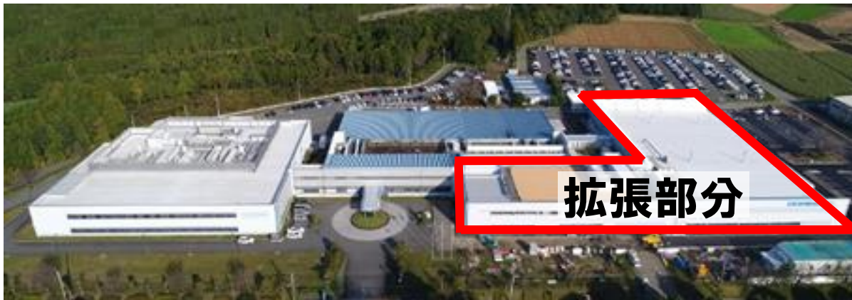
堀場エステック阿蘇工場外観
