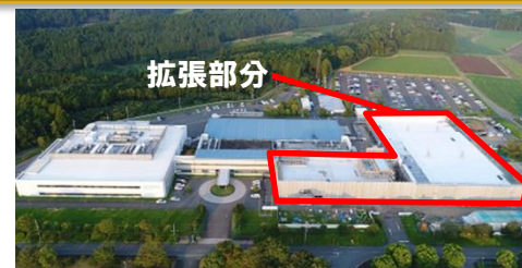
堀場エステック阿蘇工場工事状況
