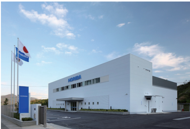
Figure 1 京都福知山テクノロジーセンター
