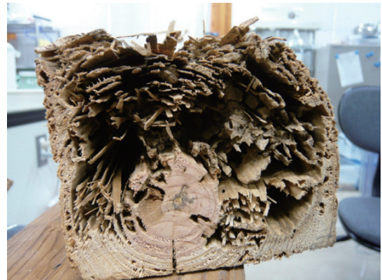
Figure 2 シロアリに食害された木材の断面 年輪沿いに、柔らかい場所から食害される。
