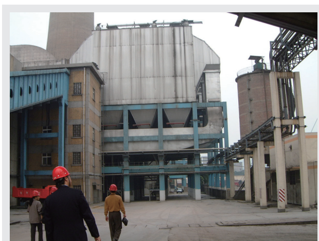
図3 電気集塵機 火力発電所
