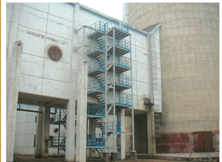
図1 ENDA-600ZGシリーズを設置した山東省棗荘市300 MW火力発電所
