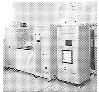
図4 気象庁気象ロケット観測所に設置された大気中のCO 2 観測システム CO 2 Monitoring system installed at the Ryori Rocket Observation Station of the Japanese National Meteorological Agency
