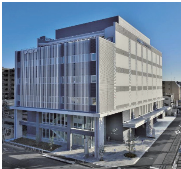
Figure 1 堀場テクノサービス本社ビル
