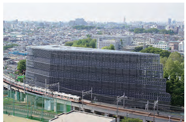
Figure 3 東工大環境エネルギーイノベーション棟(EEI棟)の外観写真(大岡山キャンパス)
