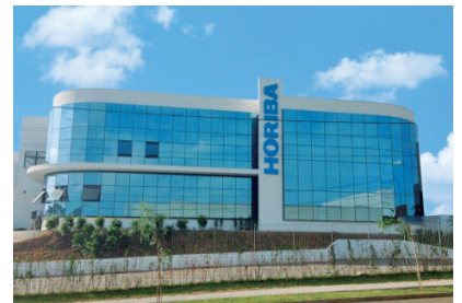
Figure 6 HORIBAブラジル試薬工場の外観
