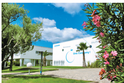
Figure 1 HORIBAメディカルフランス本社外観
