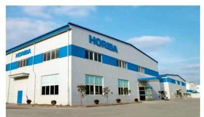
Figure 8 HORIBA上海工場の外観
