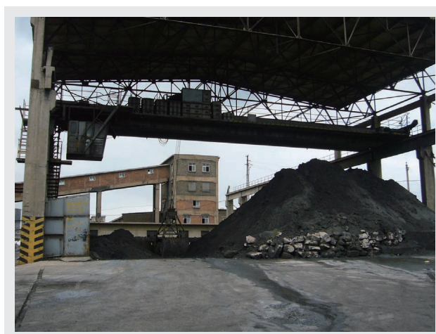
図4 石炭倉庫 一般工場
