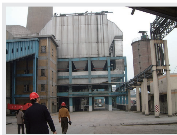
図3 電気集塵機 火力発電所
