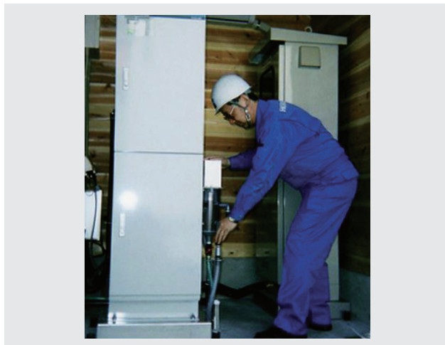
図2 自動全窒素・全りん測定装置TPNA-300据付の様子
