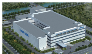
堀場儀器(上海)有限公司 (新拠点2021年完成予定)
