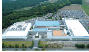
堀場エステック 阿蘇工場
