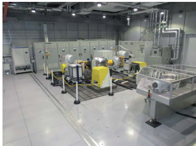
Figure 4 テストセル1機器設置の様子
